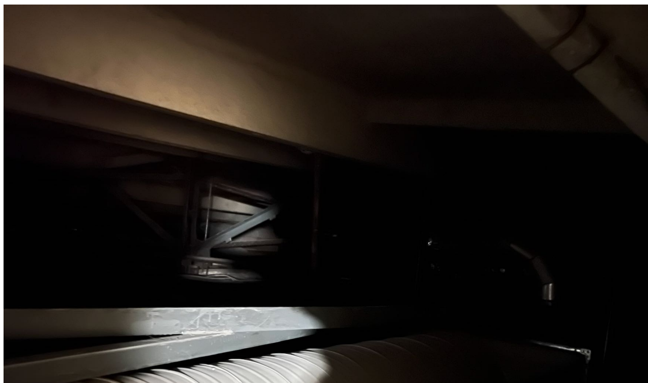
Denginio virš aktų salės konstrukcijos - briaunotos gelžbetoninės plokštės ant plieninių santvarų.
