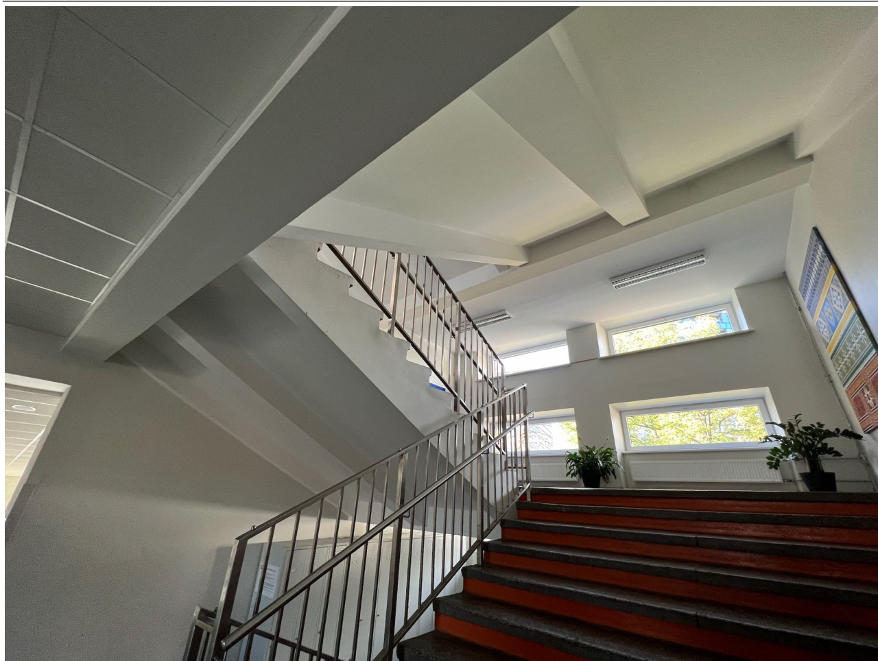
Laiptų konstrukcijos - monolitinio gb sijos ir plokštės, teracinės pakopos.
