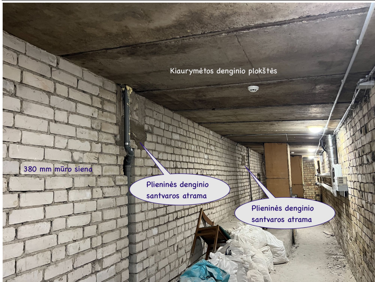
Techninio aukšto vidinė siena ir denginio plokštės.
